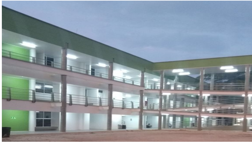
Edificación SENA Regional Caquetá
