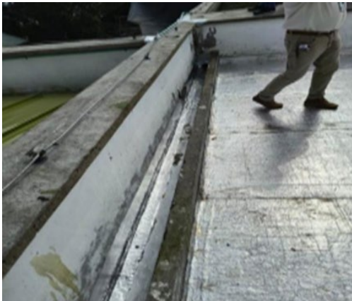
Ilustración 27 Cambio y Reposición de manto asfáltico y recuperación de cubiertas (Fuente propia)
