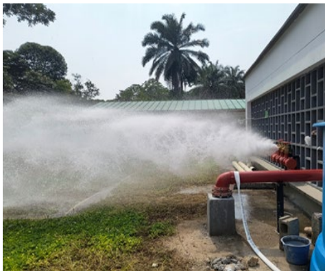
Ilustración 28 Gabinete y válvulas agua y pruebas gabinete (Fuente propia)
