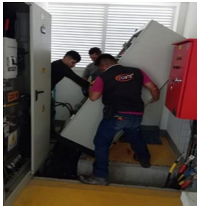
Ilustración 25 Instalación de equipo de transferencia (Fuente propia)
