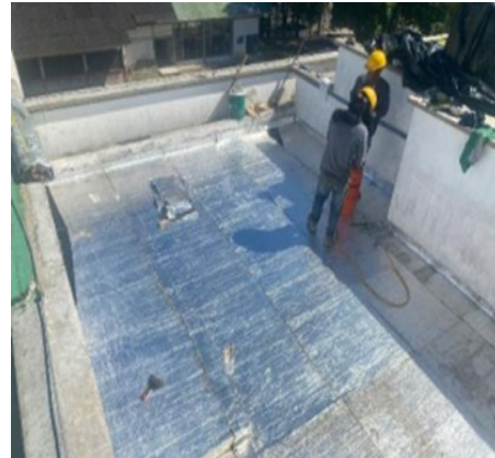
Ilustración 27 Cambio y Reposición de manto asfáltico y recuperación de cubiertas (Fuente propia)
