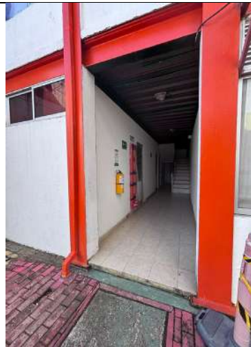
Ubicación de extintores o equipo de combate de incendios, camilla y ruta de evacuación
