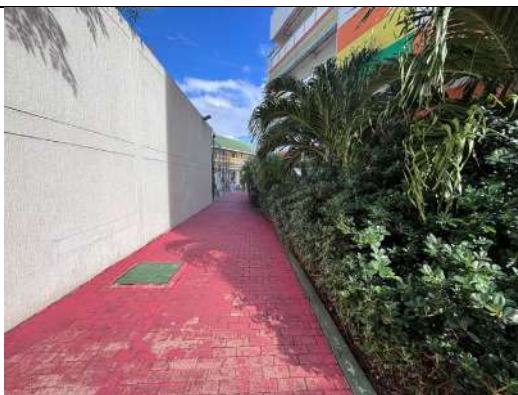
Acceso peatonal al auditorio principal
