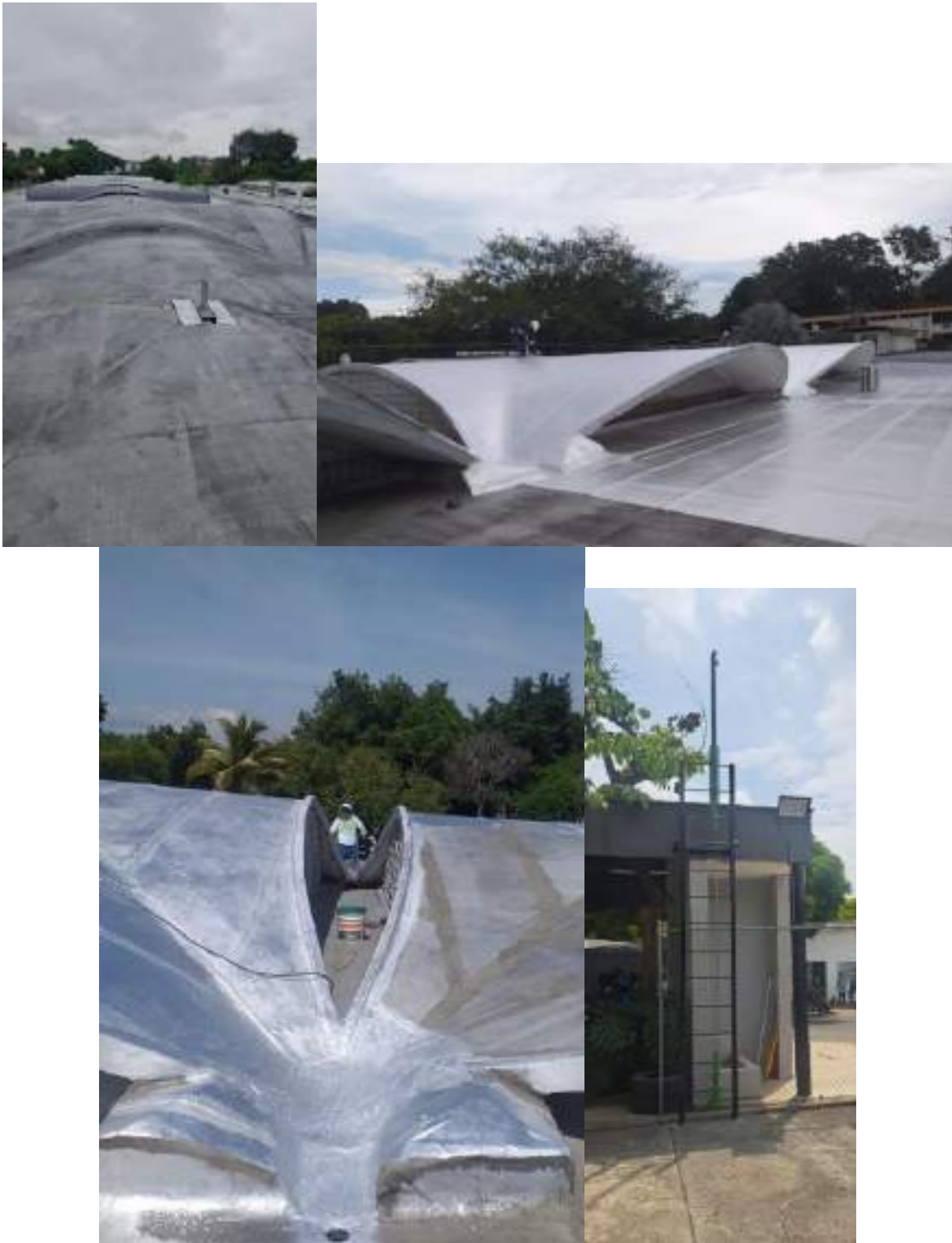
Imagen 92, 93, 94, 95 y 96. Adecuación línea de vida.
