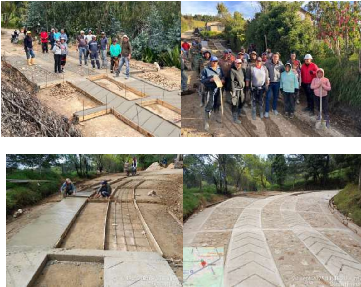
Ilustración 1 Construcción de placa huella
