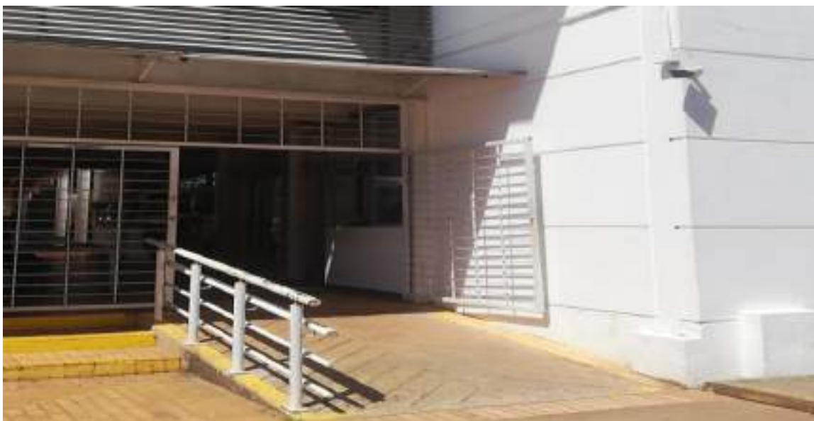
Ilustración. Rampa de acceso al centro de formación.
