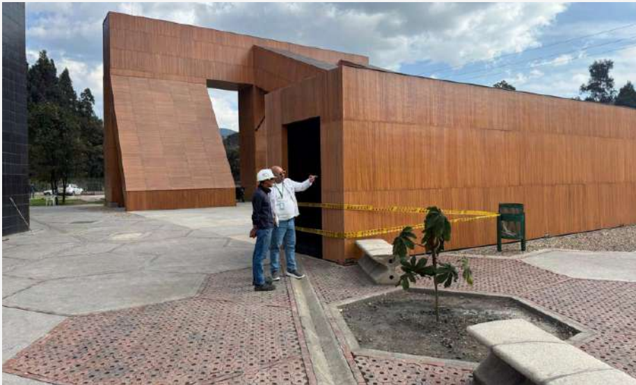
La infraestructura de la nueva sede en Guachetá continúa tomando forma para ampliar las oportunidades educativas en el territorio. Foto: Oficina de Comunicaciones Regional Cundinamarca.
