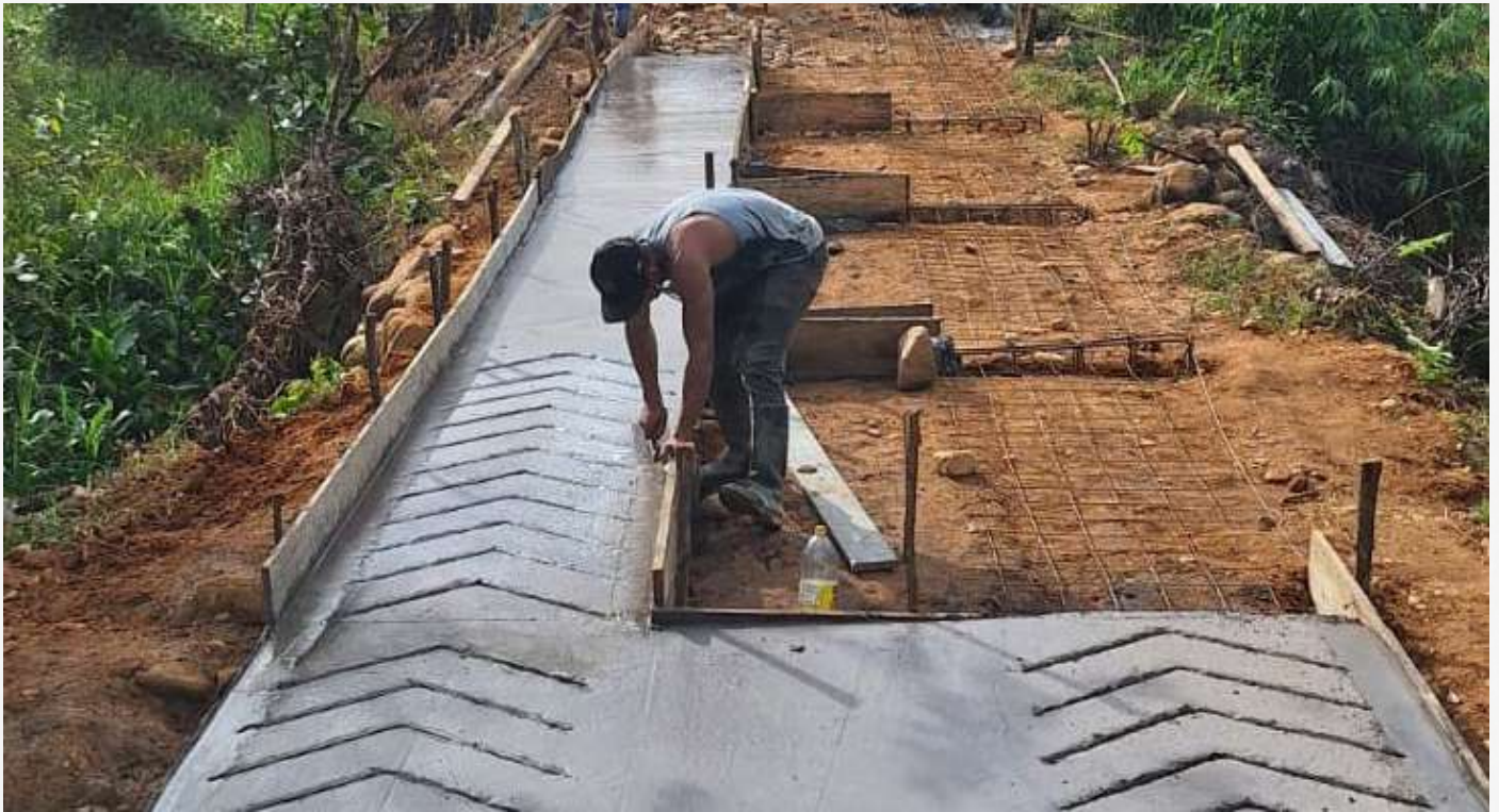
Aprendices del SENA construyeron 18 metros lineales de placa huella y una alcantarilla en el municipio de Vista Hermosa (Meta). Foto Regional Meta.
